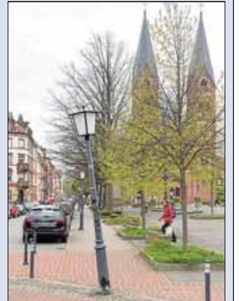
Schiefelage: Noch in diesem Jahr wollen die Stadtwerke mit der Erneuerung der Laternen in der Weststadt beginnen. Foto: Rothe
