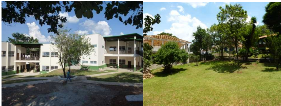
Corrente de Luz – zukünftige Schulgebäude und Außengelände
