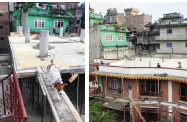
Baustelle am Hauptzentrum der Shanti Leprahilfe in Kathmandus Stadtteil Tilganga. Hier entstehen neue Klassenräume.
